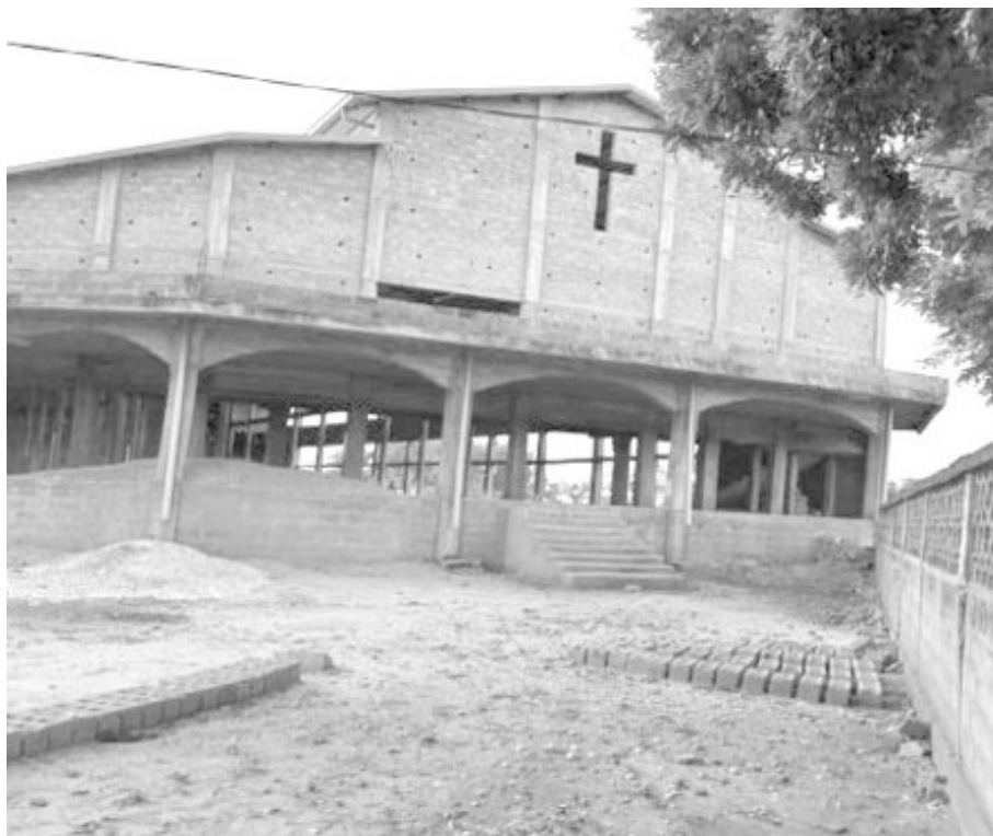
Église Notre-Dame de la Divine Miséricorde de Ségbé-Comè en construction
